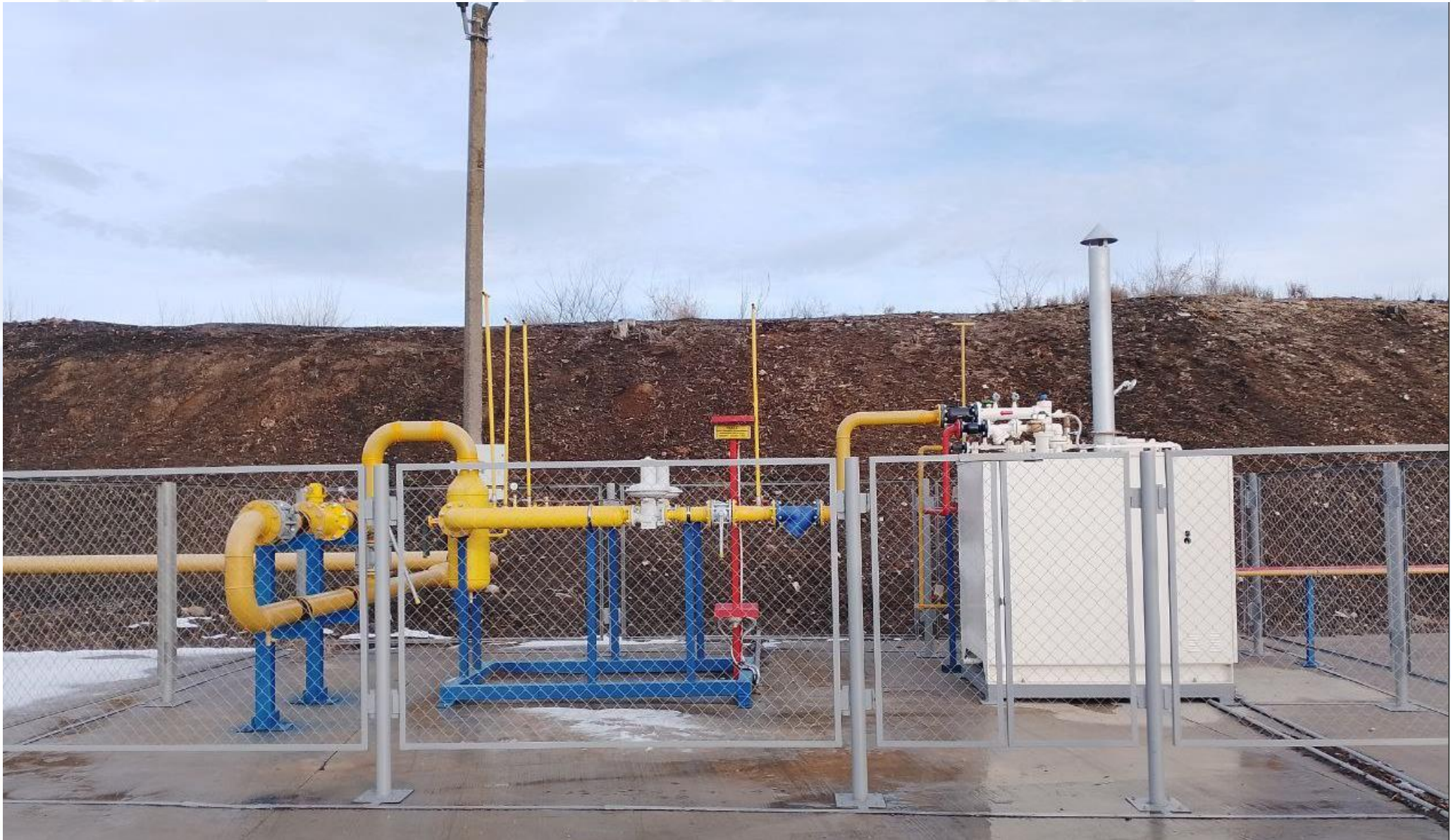
Газопостачання елеватора 20 Мвт – автономний випаровувач
